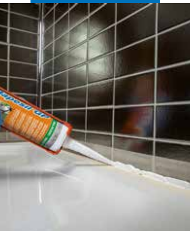
Sellado de la conexión entre diferentes materiales
