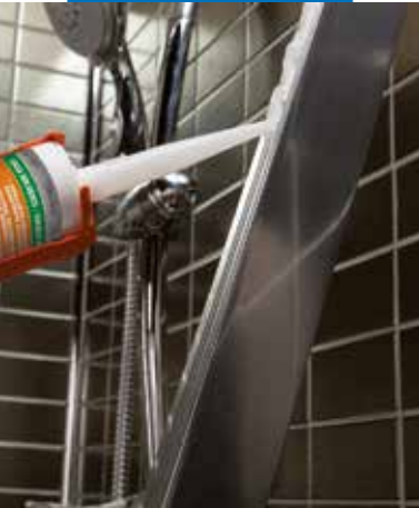
Encolado de perfiles metálicos
